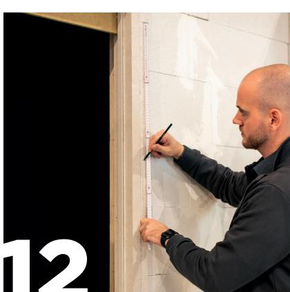
Nach dem Ausrichten wird das Zargenteil mit der Wand verschraubt. Diese Ansicht zeigt die Zarge mit Verschraubungspunkten. Wir empfehlen einen Abstand von ca. 50 cm zwischen den Schrauben.
